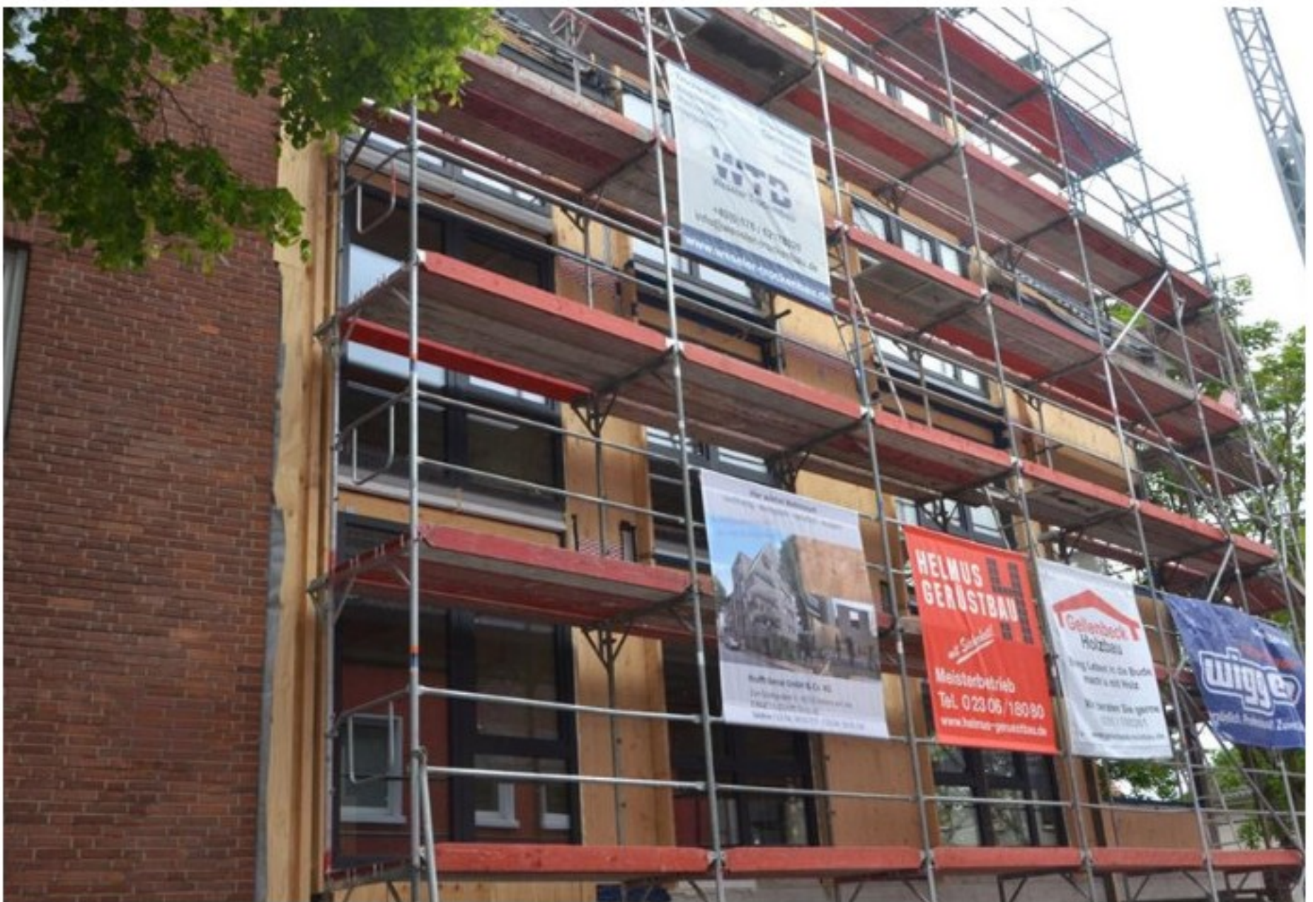
Am Alisowall 14 ist das erste mehrstöckige Holz-Wohnhaus Halterns im Rohbau fertig. © Foto:Elisabeth
